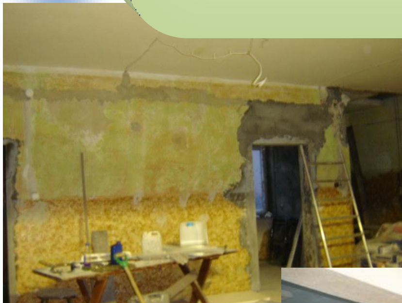
Świetlica Zagajowie w trakcie remontu (2010r)
